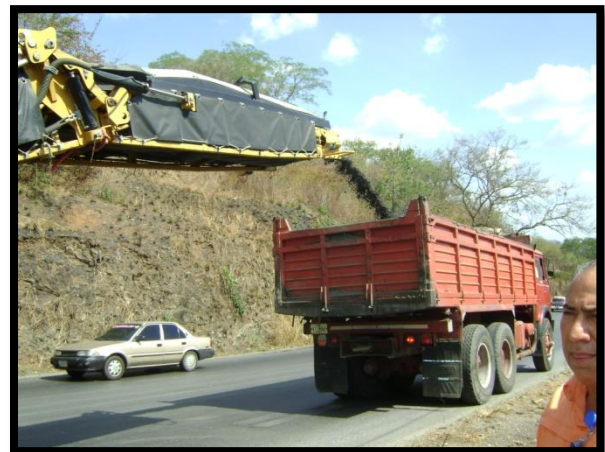
Figura 50: Imagen, fresadora escarificando en la T005.
