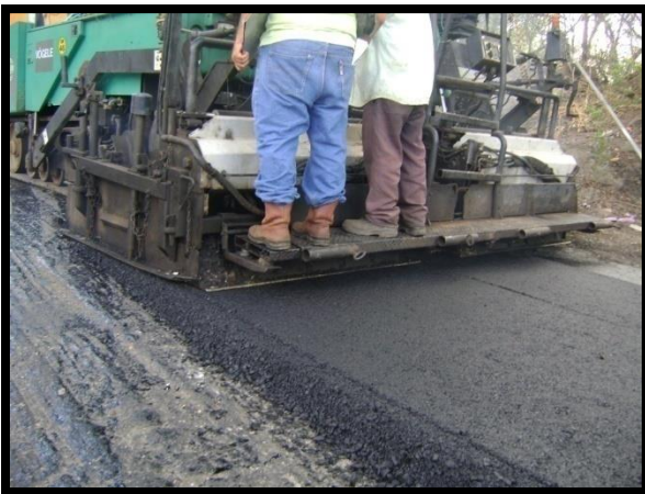
Figura 36: Imagen, Maquina finish, espesor de asfalto de 7 cm
