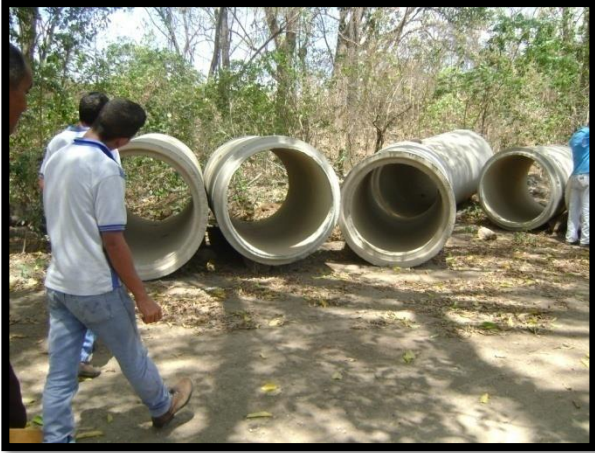
Figura 43: Imagen, Tubo de concreto para sustituirlo por los metálico ya habían cumplido su vida útil.
