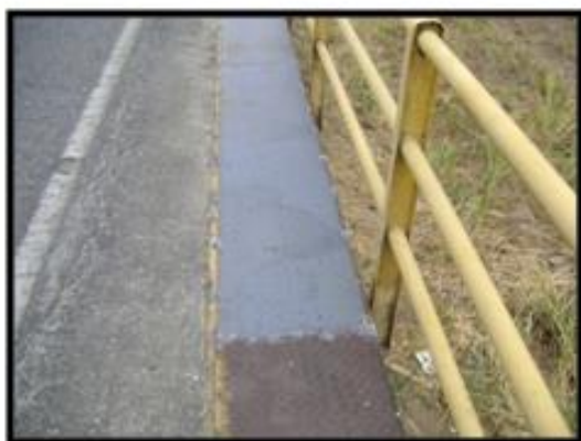
Figura 81: Imagen, sustitución Lámina estriada de 3 mm, 2,40*0,40 fueron colocada 7 lámina.
