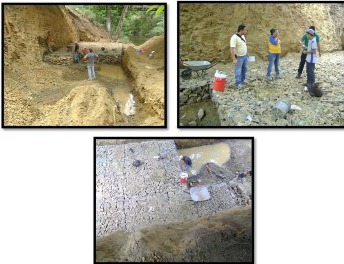
Figura 3. Imágenes de Gaviones.
