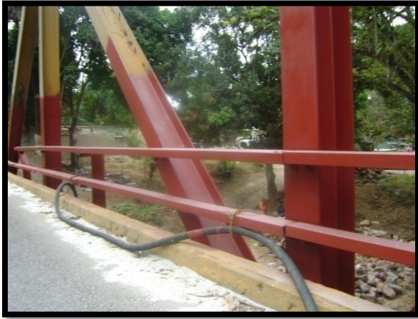
Figura 22: Imagen, ya pintada la estructura del puente.
