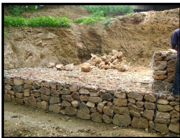
Figura 9: Colocación de piedra para Gaviones.
