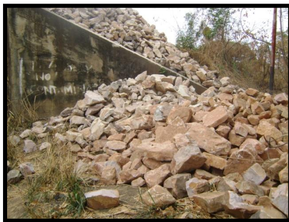
Figura 10: Imagen, Medición del área donde van hacer colocado el muro de Gavión.
