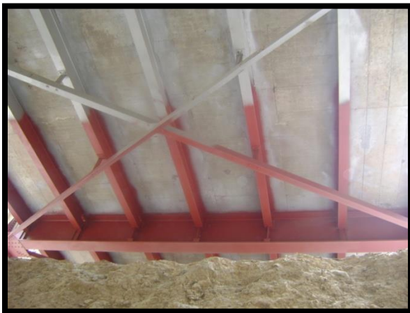
Figura 24: Imagen, fondo y pintura a la estructura.
