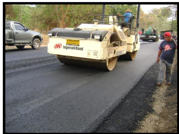
Figura 37: Imagen, Vibro Rodillo compactador.
