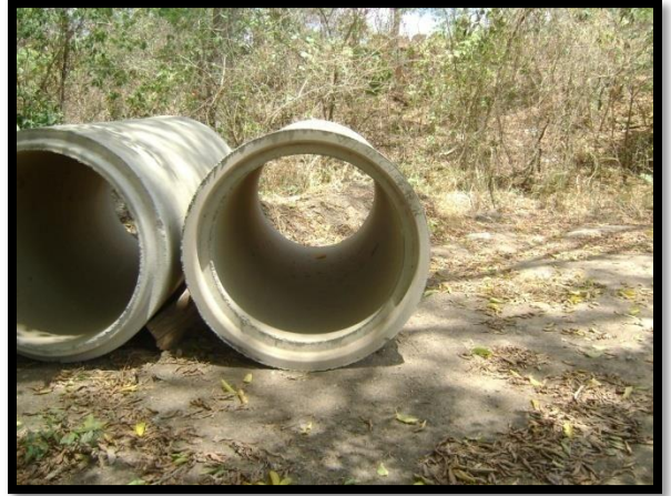
Figura 43: Imagen, Tubo de concreto para sustituirlo por los metálico ya habían cumplido su vida útil.
