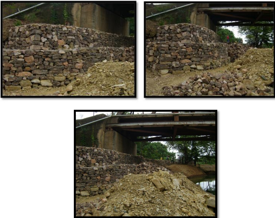
Figura 14: Imagen, Ya culminado de Gaviones en el Puente de El Pueblito.
