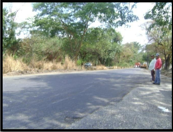
Figura 30: Imagen, área donde va hacer asfaltado.
