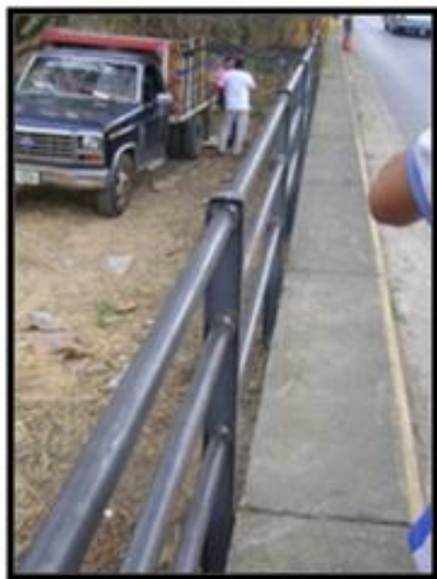
Figura 79: Imagen, Tubo y viga IPN sustituido
