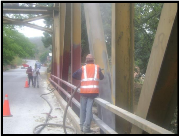
Figura 21: Imagen, Manguera y limpieza a la estructura de puente Tamanaco.
