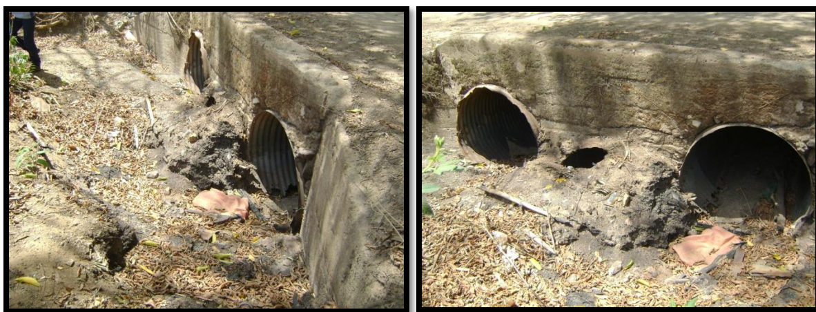
Figura 42: Imagen, Alcantarilla triple (3).
