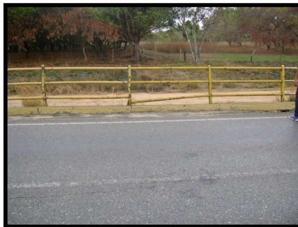
Figura 77: Imagen, sustitución tubo del puente Mapuey de \varnothing 2'' espesor 2,5 mm
