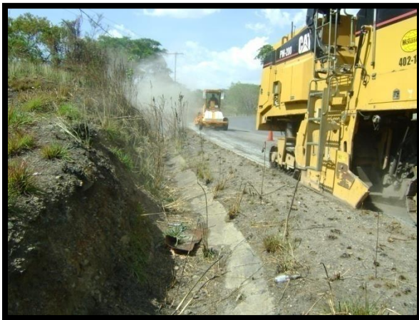
Figura 50: Imagen, fresadora escarificando en la T005.
