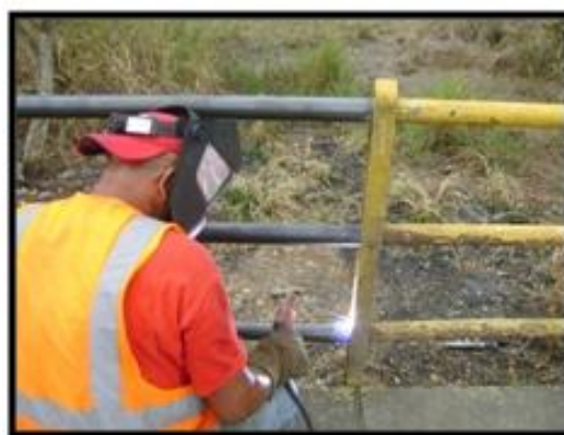
Figura 79: Imagen, Tubo y viga IPN sustituido
