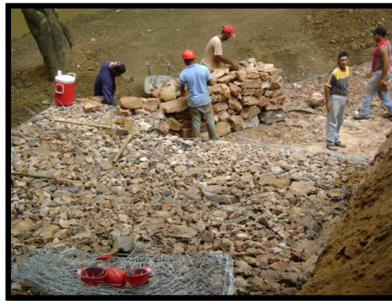
Figura 8: Imágenes, colocación de piedra para Gaviones.
