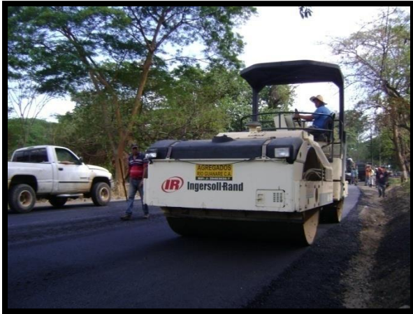
Figura 34: Imagen, Vibro Rodillo compactador.
