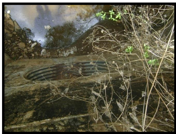
Figura 66: Imagen, el agua se llevo la alcantarilla.
