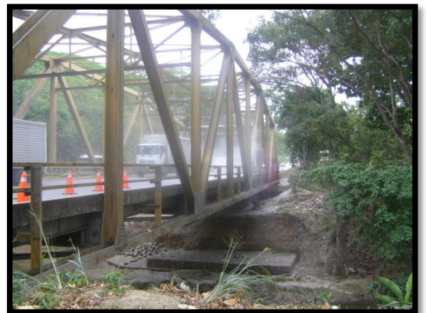
Figura 25. Imagen limpieza a la estructura con el Sand – blasting.
