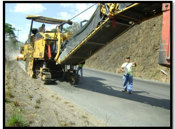
Figura 49: Imagen, fresadora maquina para escarificar.
