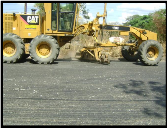
Figura 26: Imagen, Motoniveladora haciendo las limpieza de las orillas.
