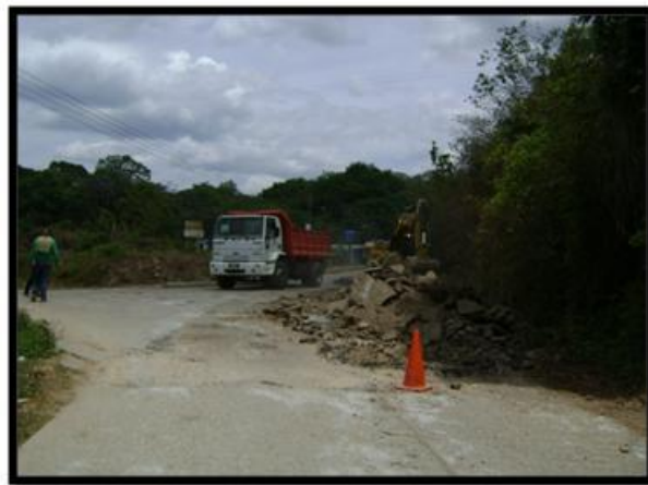
Figura 18: Imágenes del área removida y cargado en el camión.
