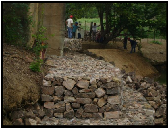
Figura 13: Imagen, Se hicieron las mediciones de los Gaviones.
