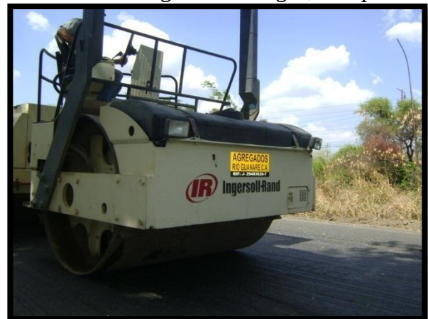
Figura 29: Imagen, Vibro Rodillo Compactador.
