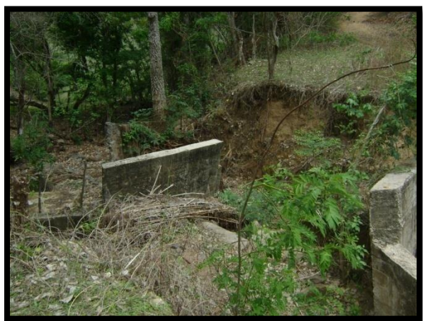
Figura 66: Imagen, el agua se llevo la alcantarilla.
