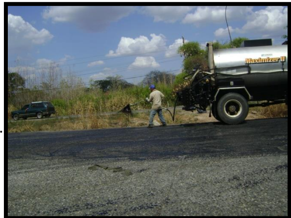
Figura 33: Imagen, Aplicando el liquido (RC2), para colocar el asfalto.
