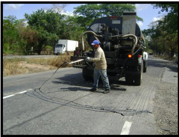
Figura 32: Imagen, Aplicando el liquido (RC2).
