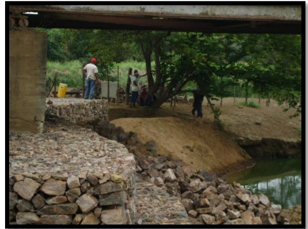
Figura 13: Imagen, Se hicieron las mediciones de los Gaviones.
