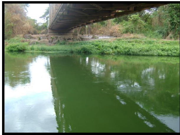
Figura 11: Imagen, De inspección en el puente El Pueblito.
