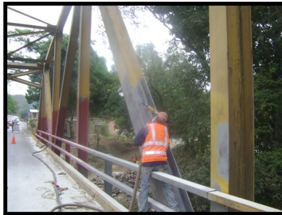
Figura 23: Imagen, quitándole la pintura a la estructura del puente con el Sand – blasting.
